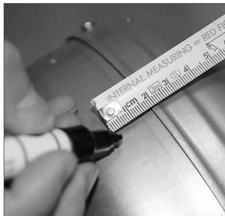
**2.** Anschließend die C-Maße markieren. B bei der Messung von der Überlappungsstoßkante des Ventilators ausgehen.
