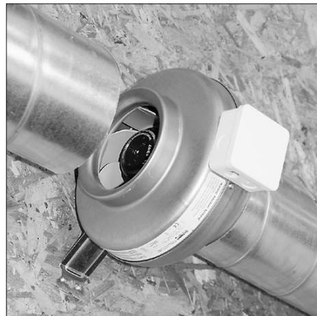
2. Rohre und Ventilator zusammensetzen.
